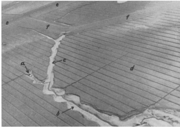
Abb. 3: Luftbild des Einleitungsbauwerkes (a), des Abwasserpriells (b), des Sommerkoogpriells (c), des Vorlandes (d), des Hauptdeiches (e) und des Sommerdeiches (f). Abstand der parallelen Gräben (Gruppen) auf dem Vorland 10 m. (Aufnahme: D. KÖNIG, 23. April 1965, Freigabe: SH - 168 - 138)
