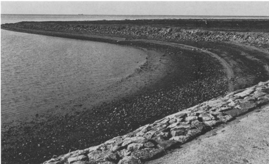
Abb. 5: Blick auf die südliche Begrenzung des Schüttkörpers. An der noch nicht abgeflachten Abbruchkante ist die Überdeckung des groben Materials mit Feinschutt erkennbar. Vorn Außenberme und schweres Deichdeckwerk
