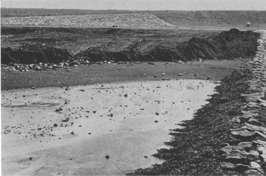
Abb. 4: Das Einbringen der Verhüttungsrückstände. Im Vordergrund Wattboden (hell), die dunklen Materialhaufen sind Feinschutt. Rechts die südlich begrenzendende Steinbühne. Im Hintergrund der Seedeich (Krone: + 7,00 m NN) mit befestigter Überfahrt
