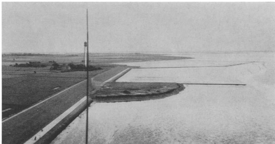
Abb. 3: Die Vorschüttung während der Baumaßnahme 1965 am Campener Leuchtturm. Blickrichtung nach Süden. Die Steinbuhne am südlichen Rand der Schüttung hat eine Länge von 175 m. Der helle (Beton-)Streifen am Außendeich ist die Außenberme, davor das schwere Fußdeckwerk
