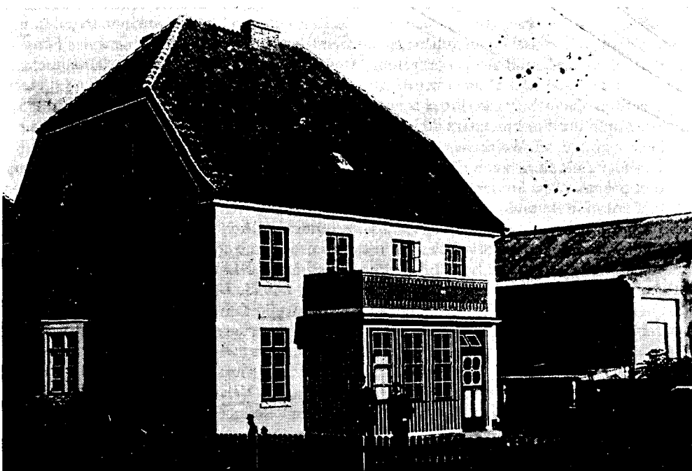
Abb. 23. Kustodenwohnhaus auf dem Oberland. Aufnahme um 1913. Archiv der Biologischen Anstalt Helgoland.
